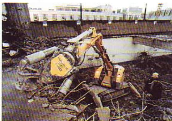
En équipant le Brokk 330 avec des cisailles à béton vous aurez une machine silencieuse qui ne gêne pas les voisins. De plus, elle travaille très vite.
