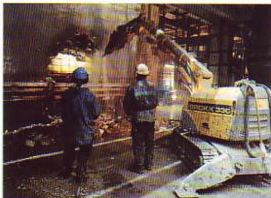
Le Brokk 330 est à l'aise lorsqu'il s'agit de gros travaux de démolition, comme ici pour la refecton d'une usine de papier.
