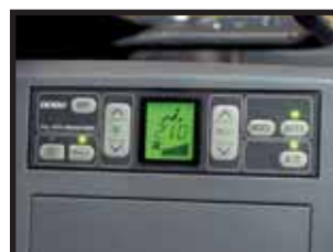
Climatisation à régulations de température
