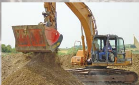
7. Criblage de terre végétale
