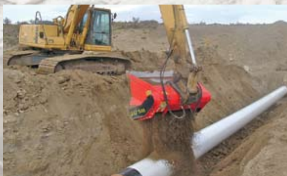
6. Remblaiement direct de tranchées
