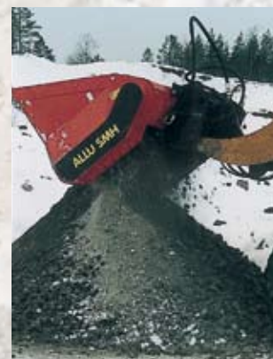
13. Broyage du béton léger
