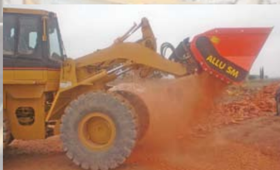
3. Broyage de briques
